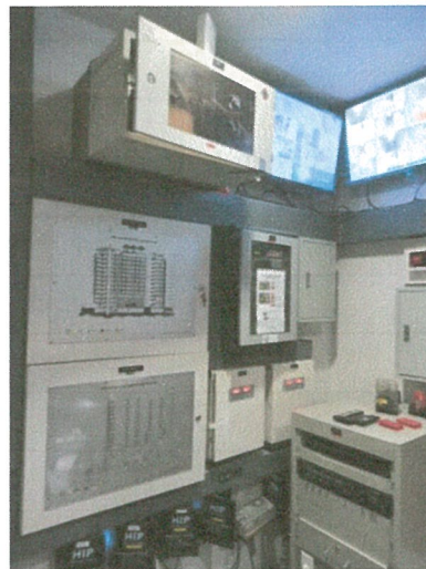
รูปภาพที่ 2.39 แผงควบคุม Fire alarm control
