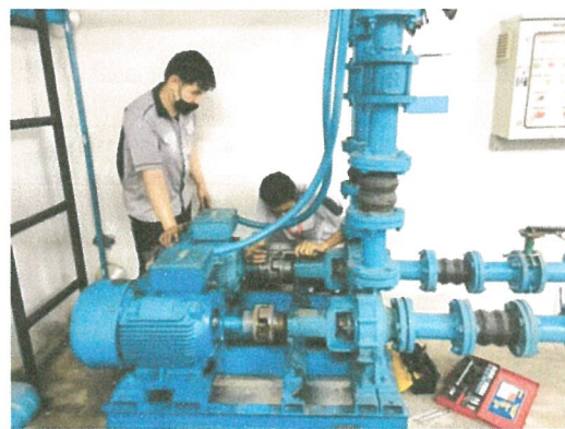
รูปภาพที่ 2.56 การตรวจสอบปั้มน้ำ
