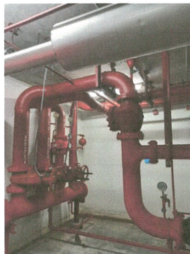
รูปภาพที่ 2.40 เครื่องสูบน้ำดับเพลิง (Fire pump)
