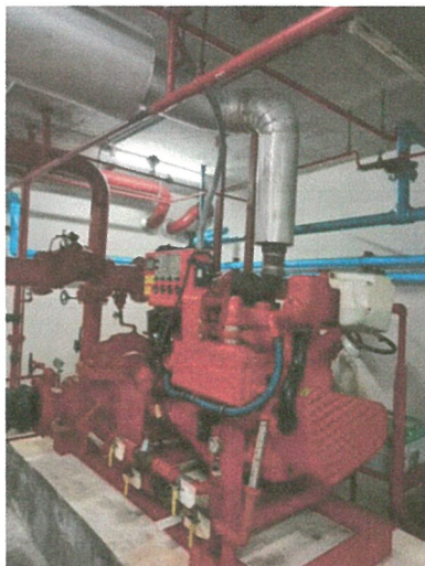
รูปภาพที่ 2.40 เครื่องสูบน้ำดับเพลิง (Fire pump)
